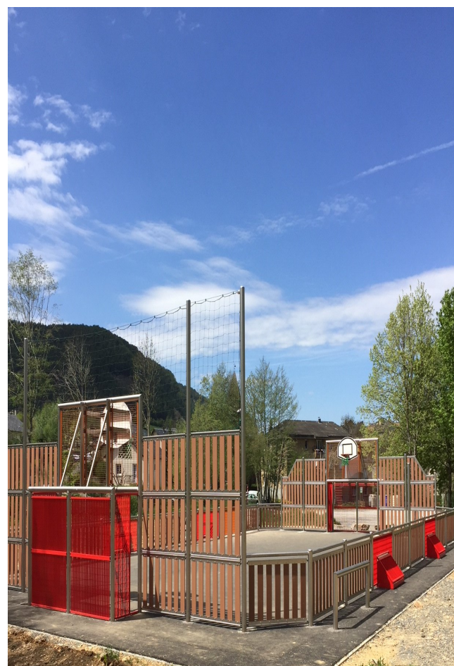
Le revêtement amortissant a été posé sur le terrain multisport vendredi 25 mai 2018.
