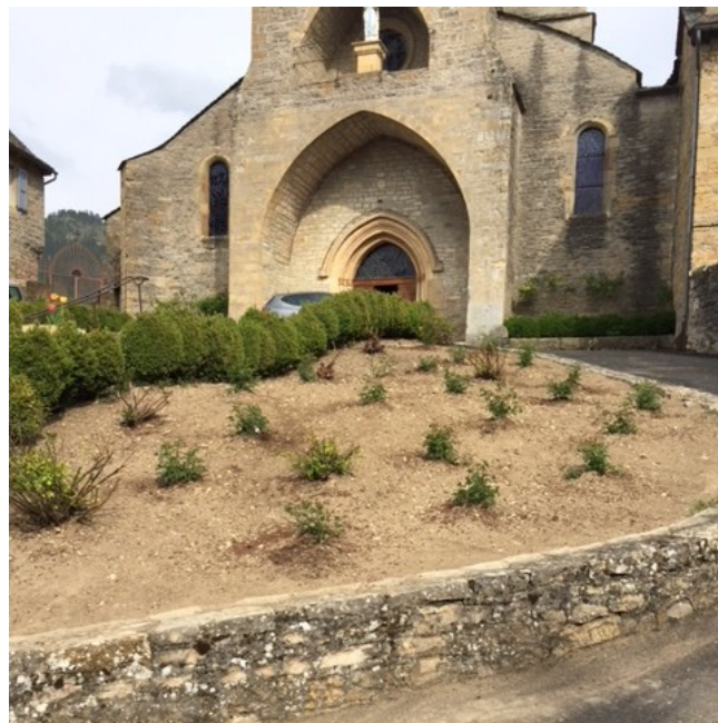
Le parvis de l'église a bénéficié d'un revêtement bitume neuf et les rosiers ont été renouvelés.
