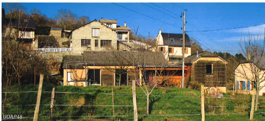
UDAP48 Maison individuelle, Nathalie Crépin architectes
