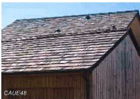
CAUE48 Logements collectifs, atelier Bessin et Sebelin
