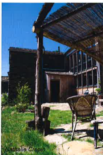
Extension, Nathalie Crepin architecte
