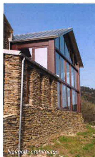
Extension, Navech architectes
