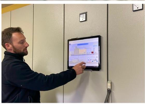
*La télésurveillance un dispositif très efficace pour surveiller les réseaux d'eau potable et d'eaux usées.*
